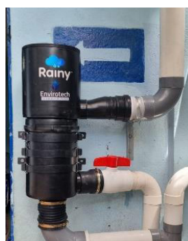
Figura 13. Ejemplos de filtros instalados en proyectos que captan agua de lluvia desde techos.
