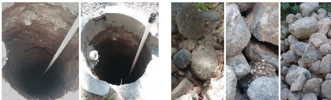
Figura 14. Procesos de limpieza de sedimentos en pozos secos
