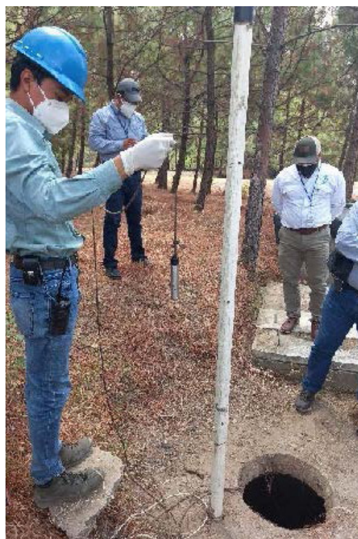
Figura 15. Ejemplo de un piezómetro instalado en un pozo seco para colocar el datalogger y protegerlo.
