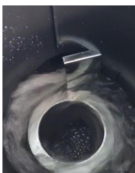
Figura 13. Ejemplos de filtros instalados en proyectos que captan agua de lluvia desde techos.
