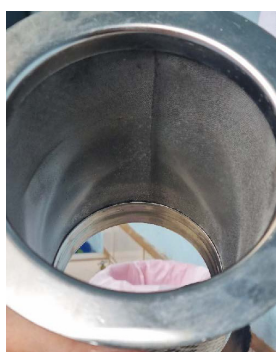
Figura 13. Ejemplos de filtros instalados en proyectos que captan agua de lluvia desde techos.
